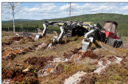
Markberedning med M36.b ger plantor och frön bästa möjliga förutsättningar att växa och överleva oavsett terräng.
